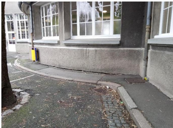
Affaissement du sol le long du bâtiment et problème d'évacuation des eaux pluviales
