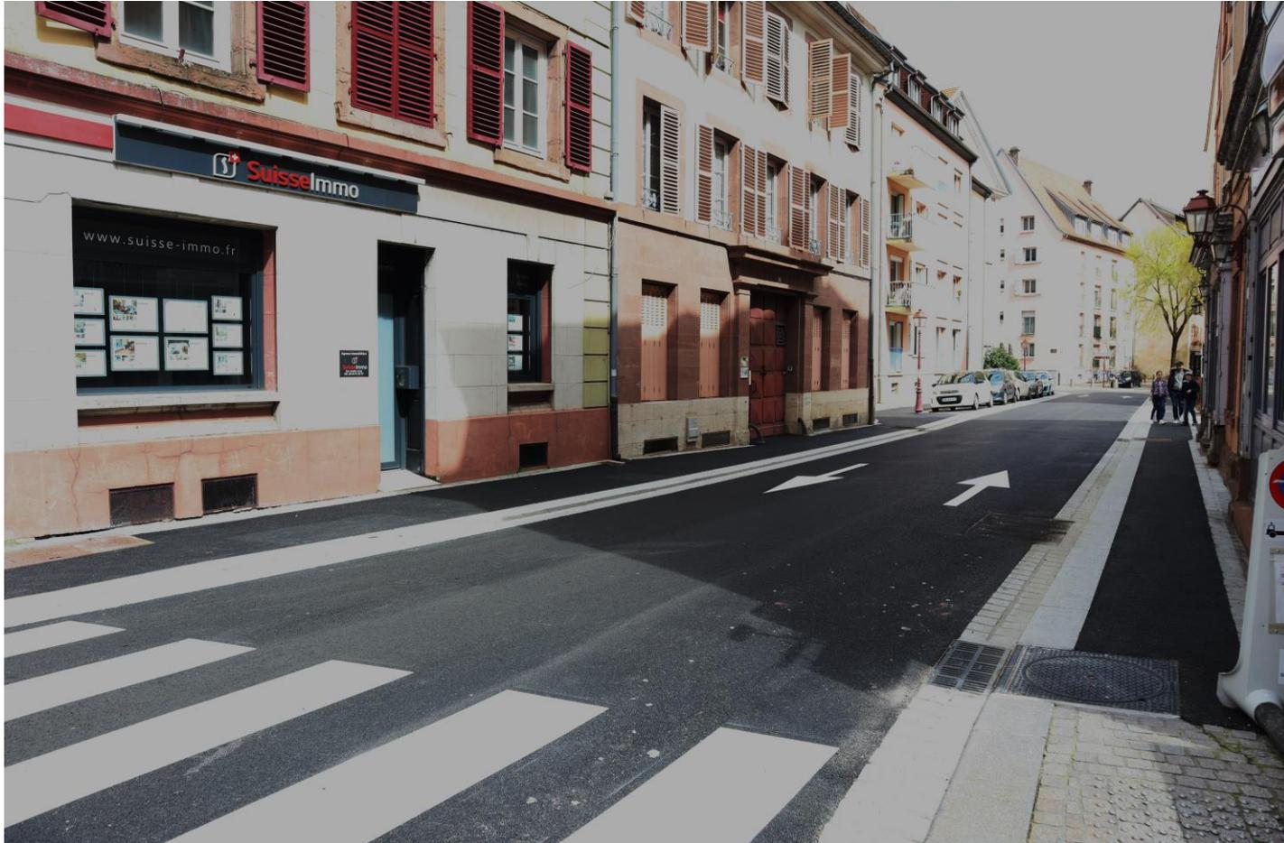
La Ville de Belfort a réalisé les travaux en mettant en œuvre la charte d'aménagement « vieille ville », sur le modèle de la rue du Général-Roussel (bordures de trottoirs moins hautes et plus larges).
